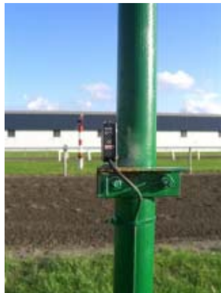
センサーの設置状況
