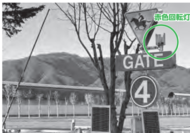
電動ゲートと連動させた赤色回転灯
