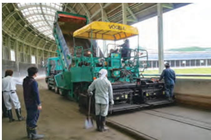
屋内 600 mトラック砂馬場のクッション砂取替え
