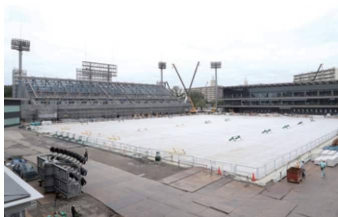
FOPの全景：仮設の観覧席や照明を整備中
