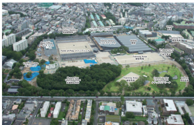
工事中の馬事公苑：2019年8月撮影
