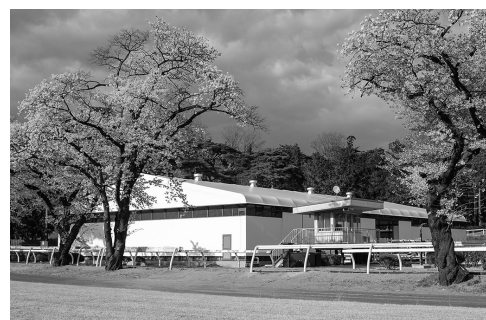
図7 馬事公苑の馬場内に新設された覆馬場
