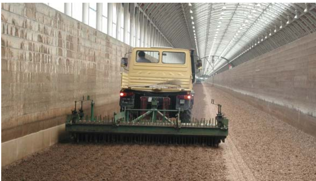
写真4 ミキシングハローによる均しと転圧
