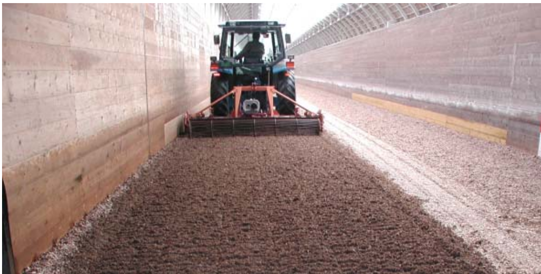
写真3 パワーハローによる混合
