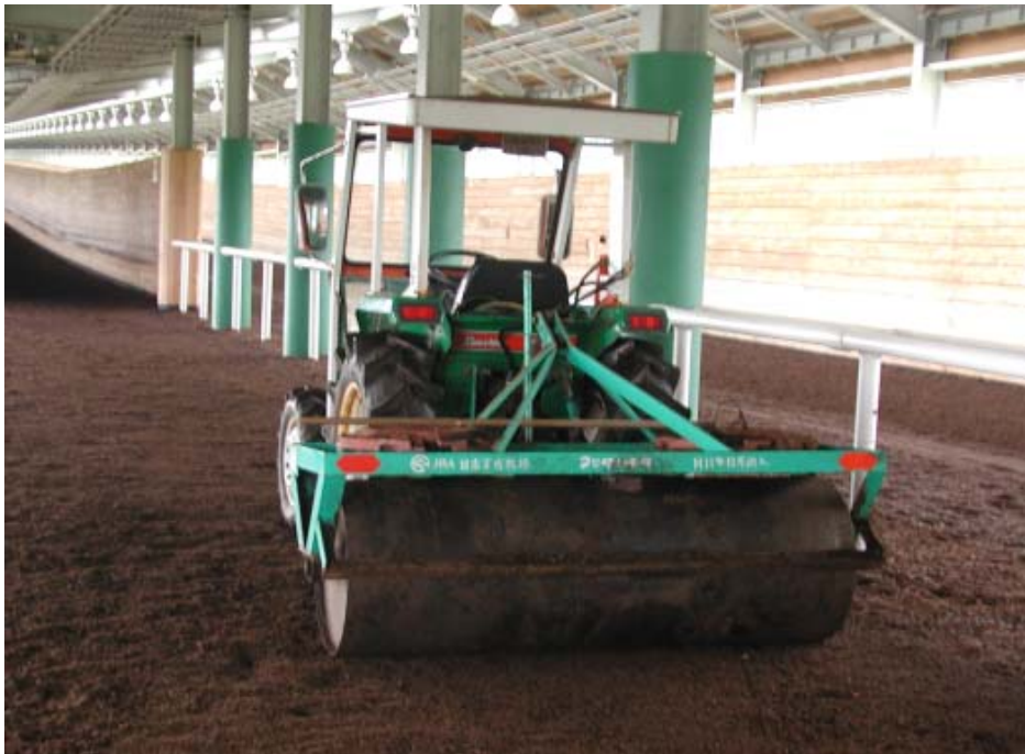
写真7 転圧ローラー
